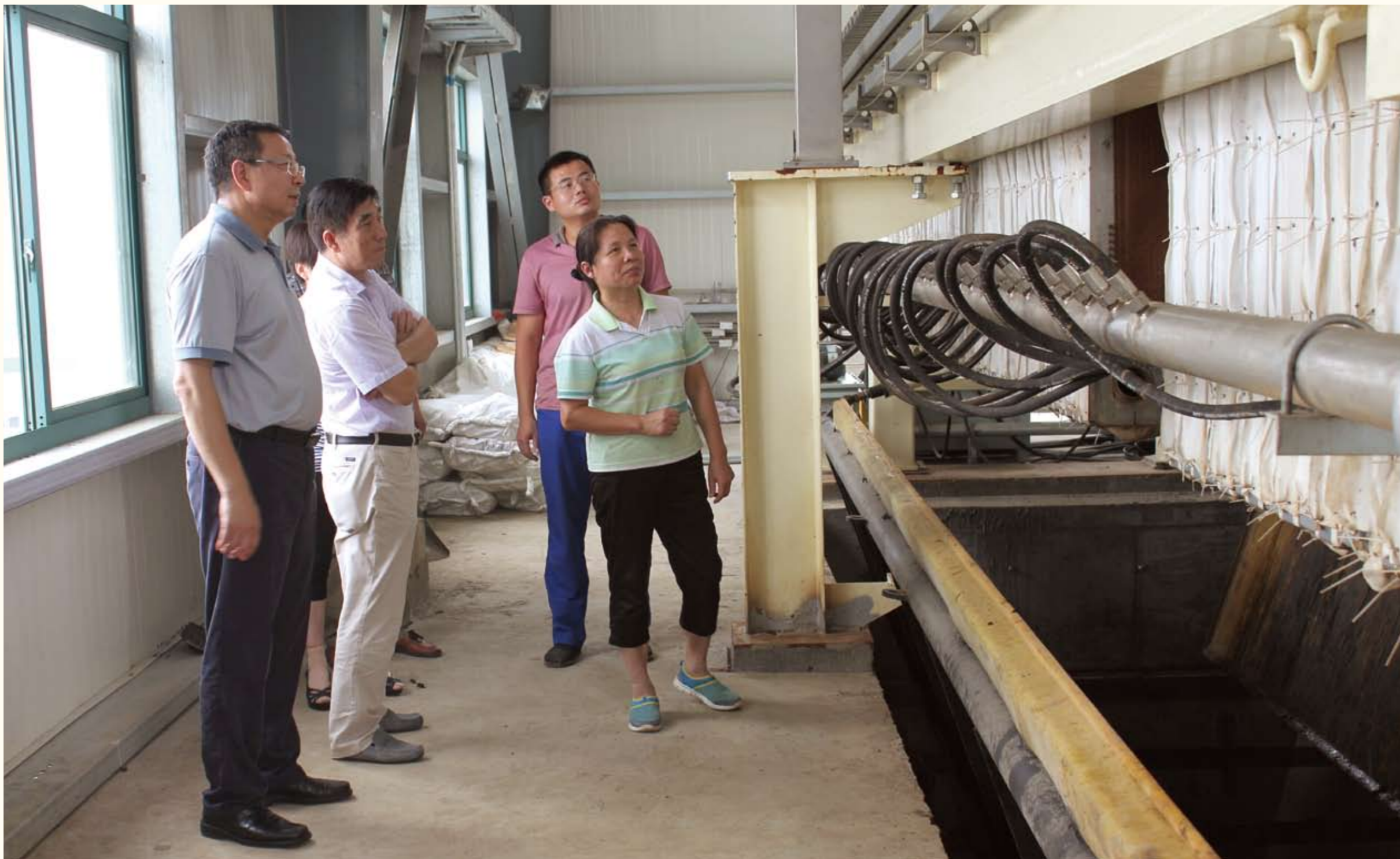
于国波一行察看污泥深度脱水泥饼卸料
